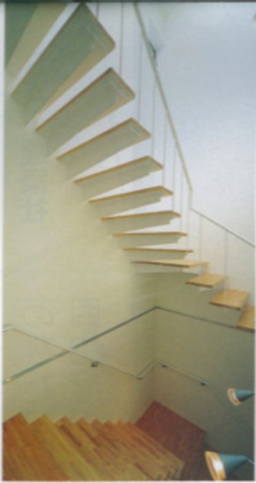
3階まで吹抜けの階段室。床上げ板を張り込まず、宙に浮いたような遊び心ある空間
