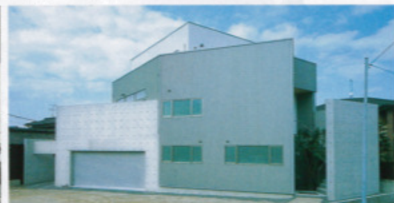
変型地形を活かしたデザインの「modern-麗の家」。1階はコンクリート、2・3階部分は木造で天然素材をふんだんに使用している
