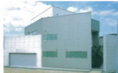
「modern+」の家。1階はコンクリート、2・3階部分は木造。変形地形を活かしたデザインが目を引く
