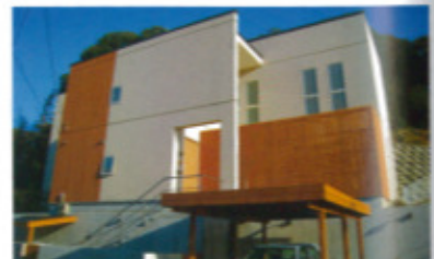
高低差のある敷地を活かし、遊びごころある大胆な設計。自然素材の取り入れ方のバランスが絶妙
