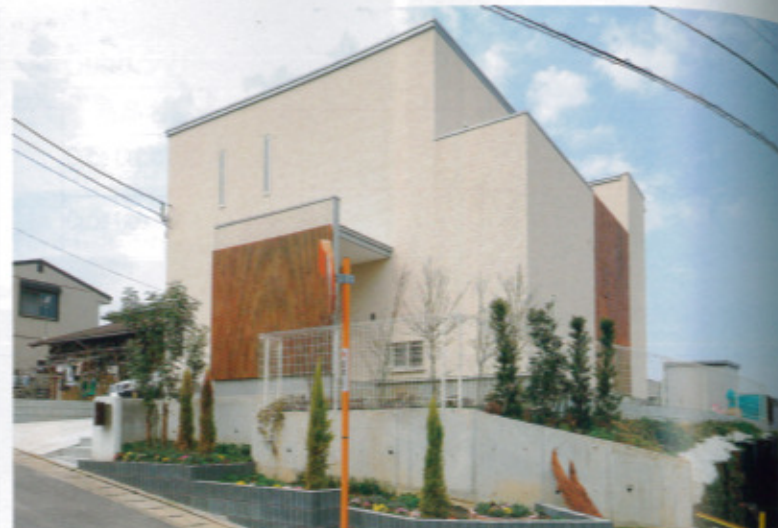
外からの視線を遮る木製のルーバー、幅16cmのスリット窓。セキュリティやプライバシーにも配慮を保ちながら、スタイリッシュに仕上げた。高低差や狭小変型など土地の特性を活かした家づくりは同社お得意の仕
