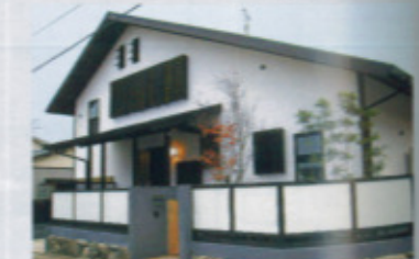
「モダン民芸調の家」玄関の庇、窓格子で和をイメージしつつ屋根で変化を出してモダンに
